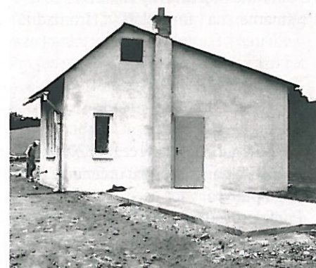
Dobová fotografie z období přesunu včelína na nové místo
